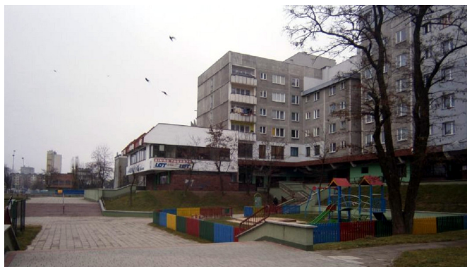
Widok od strony północnej
