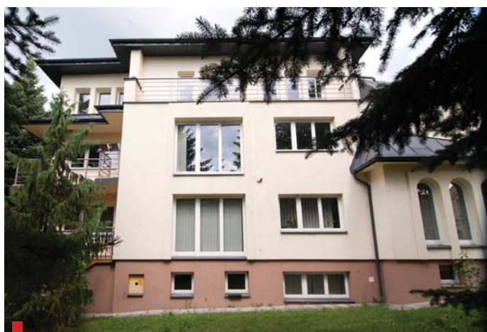
widok od strony południowej
