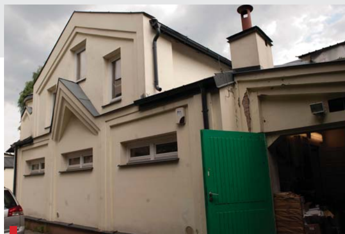
wejście do budynku- elewacja zachodnia
