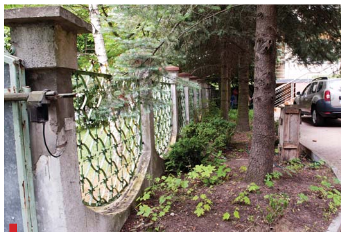
ogrodzenie budynku: widok od ul. Zbożowej
