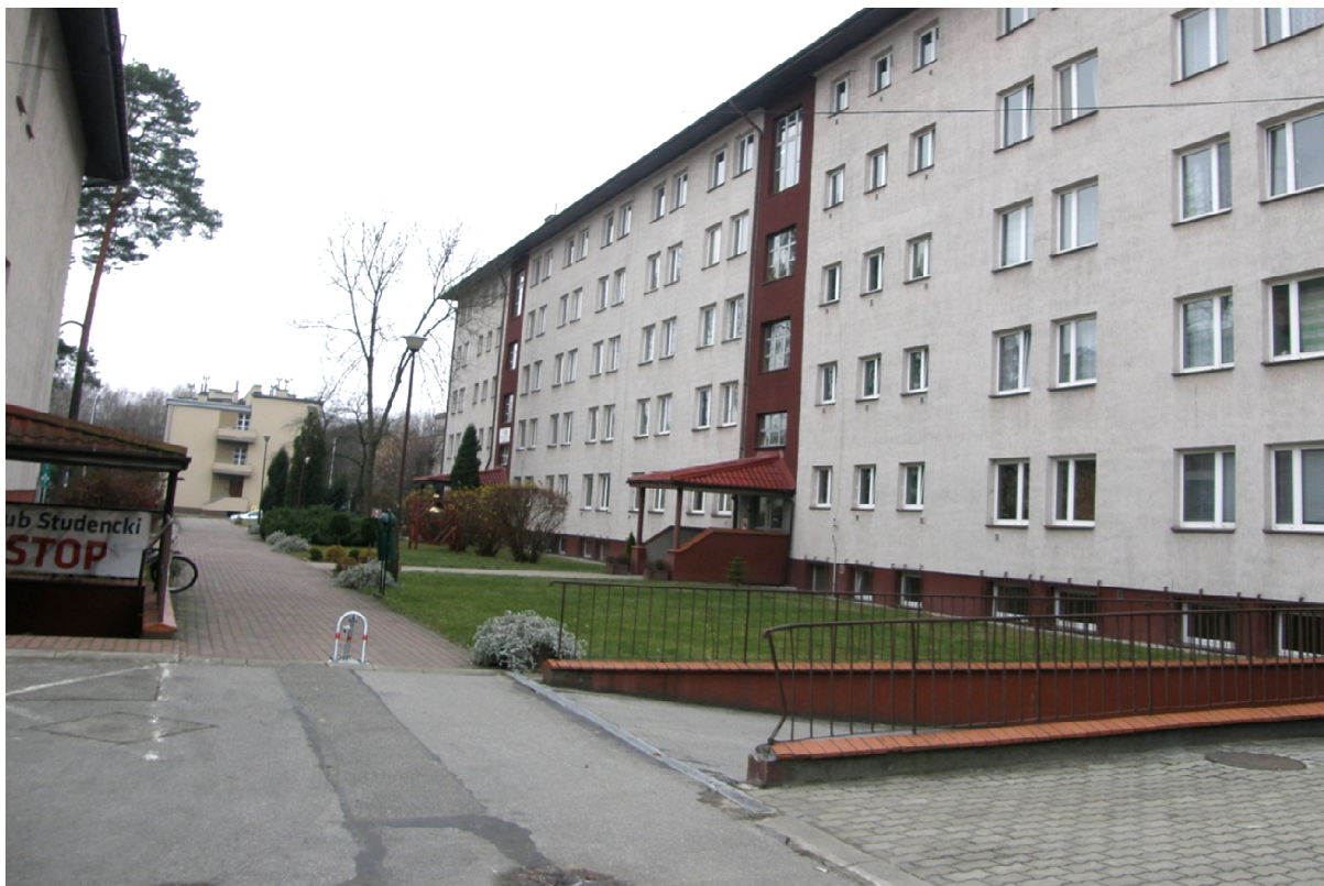
Widok na istniejący ciąg pieszo-jezdny z widocznymi murkami oporowymi pochylni i schodów
